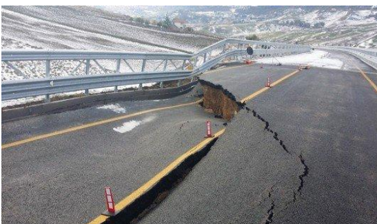
Lo squarcio nell'asfalto del viadotto Scorciavacche, il 10 aprile 2015 (Ansa)
